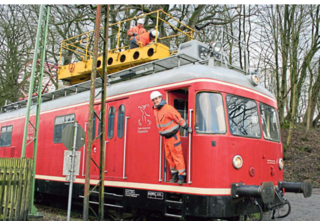
Raphael Kahlert (vorn) sowie Adrian Fahrenkamp und Frank Muth (oben) arbeiten vom Turmtriebwagen aus an der Oberleitung. Dort stehen ein neuer und ein alter Mast noch nebeneinander.
