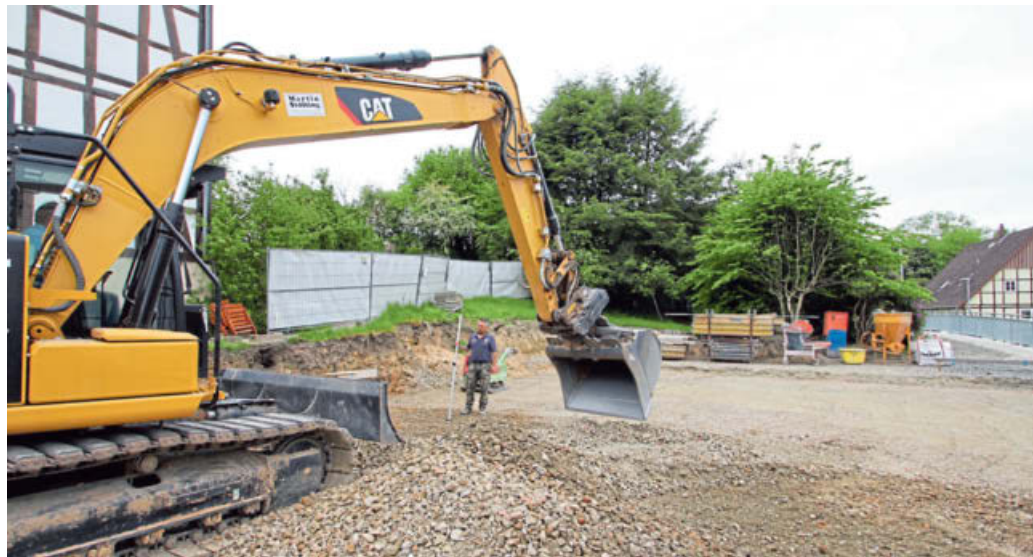
Wilfried Kracht (im Bagger) und Stefan Bargenda von der Firma Stöltzing bereiten die Fundamentierung für das neue Gemeindehaus vor. Der flache, eingeschossige Bau entsteht zwischen dem Fachwerkhäus und der Hohenhauser Straße.
