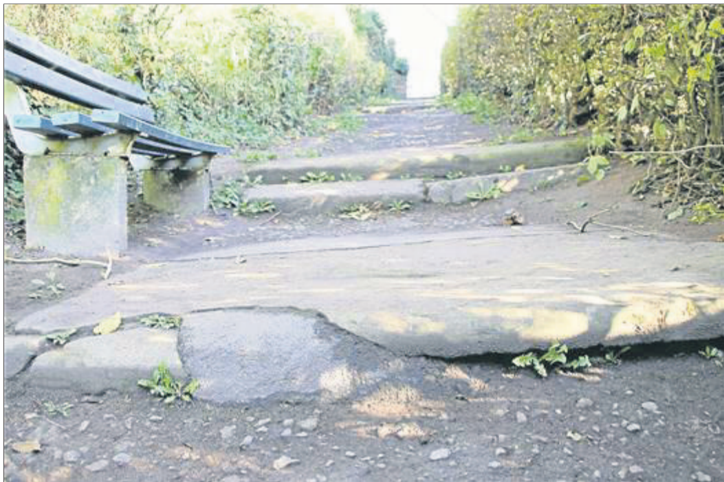
Der Fußweg zwischen Kernstadt und Erholungsgebiet Hahnebach wird jetzt instandgesetzt.
